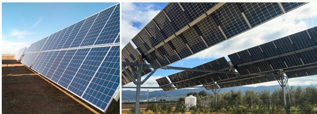
Figura 1: Esempi di tracker mono assiale 2P per agrivoltaico
